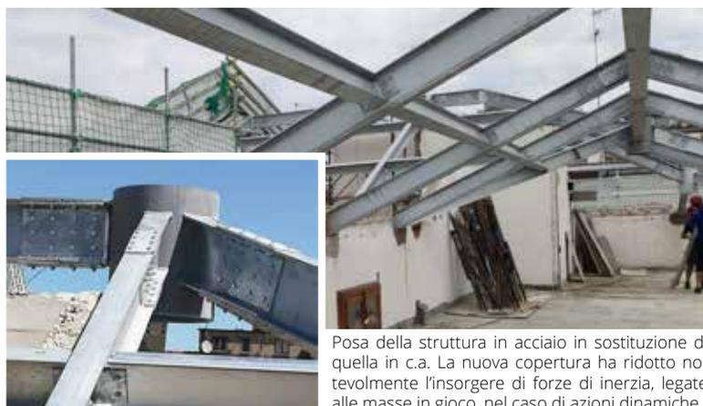
Posa della struttura in acciaio in sostituzione di quella in c.a. La nuova copertura ha ridotto notevolmente l'insorgere di forze di inerzia, legate alle masse in gioco, nel caso di azioni dinamiche
